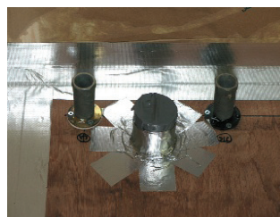
コンセント・配管廻りを気密テープ
