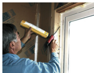
窓枠部隙間を断熱で現場発泡
